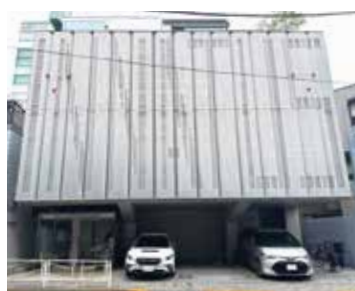
▶建築賞も受賞した自社ビル。よく見ると金属にドットの穴で社名が
